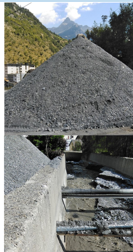
Fig. 3.5—Photos du canal du Charmaix et des matériaux excavés
