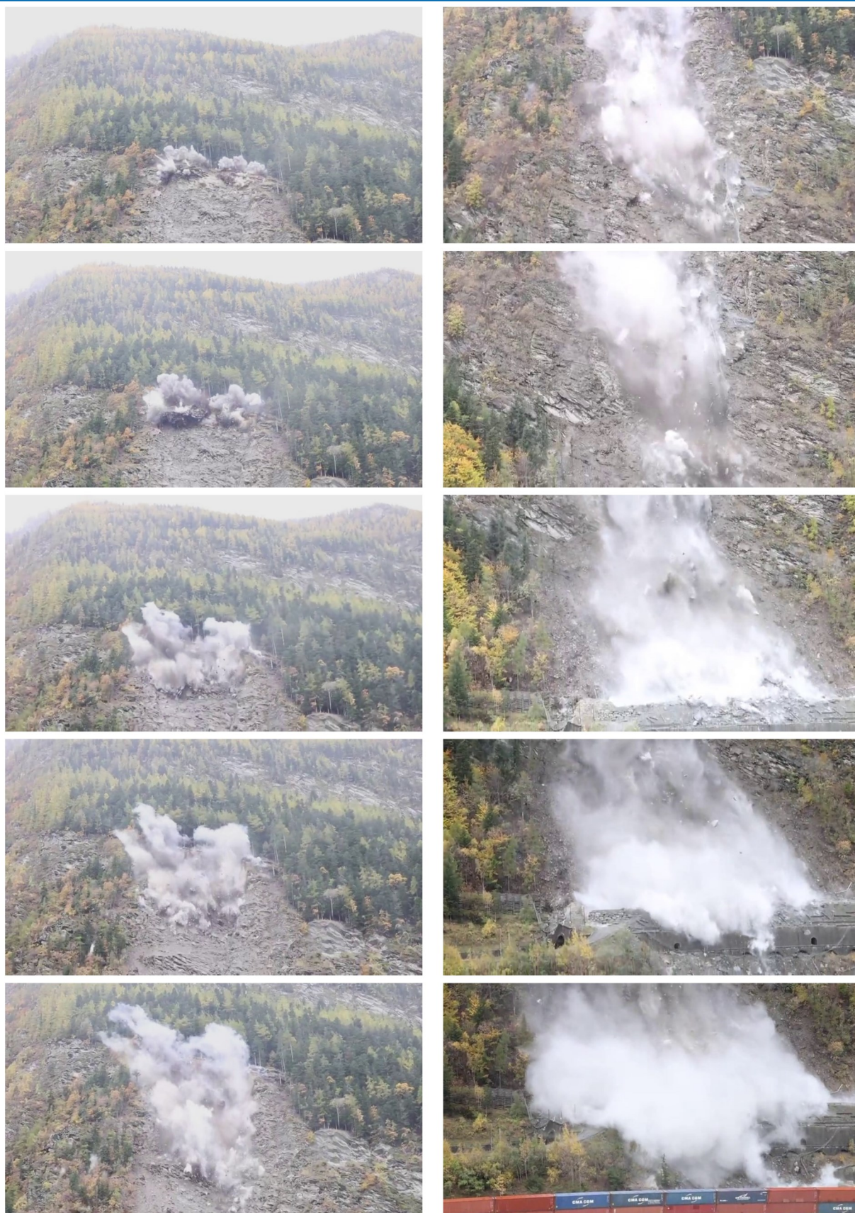
Fig. 2.7— Aperçu d'un tir de sécurisation de la paroi de l'écroulement du Freney
